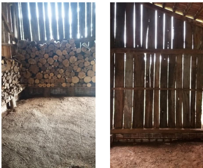
Figura 6 – Limpeza das paredes e chão.
