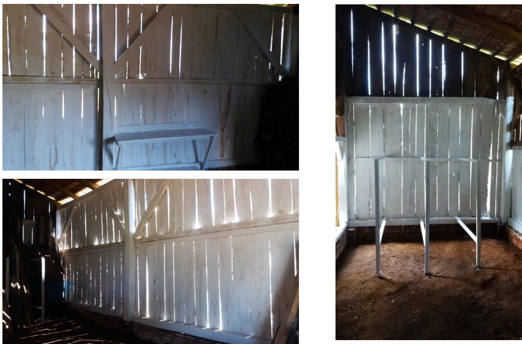
Figura 7 – Pintura das paredes e montagem das prateleiras para combustíveis e separadores para madeiras.
